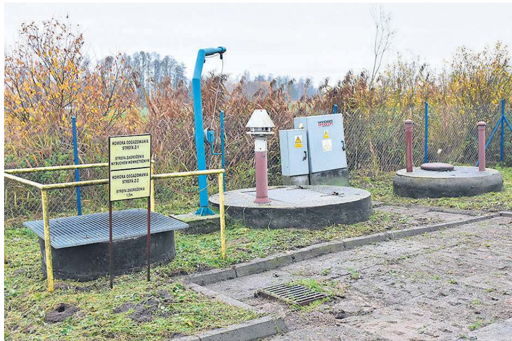
Modernizacja przepompowni ścieków PK-1 Kęsowo ma kosztować ponad 460 tys. zł. Jak tłumaczy Justyna Banaszek-Turzyńska, prace są konieczne ze względu na wiek i stan techniczny sprzętu.
