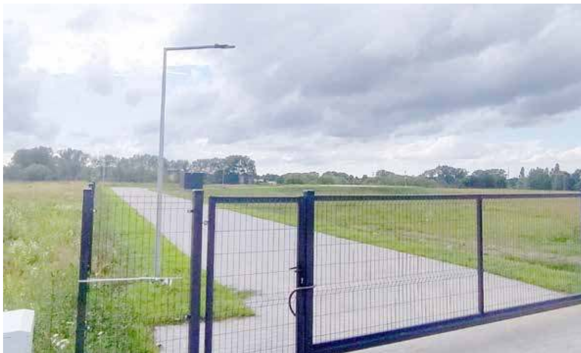
Sam obiekt wybudowany za bramą wjazdową jest już gotowy
