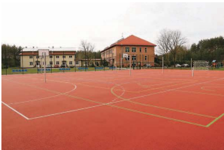
Nowy obiekt sportowy powstał w sąsiedztwie Publicznej Szkoły Podstawowej w Woli rzeczyckiej
