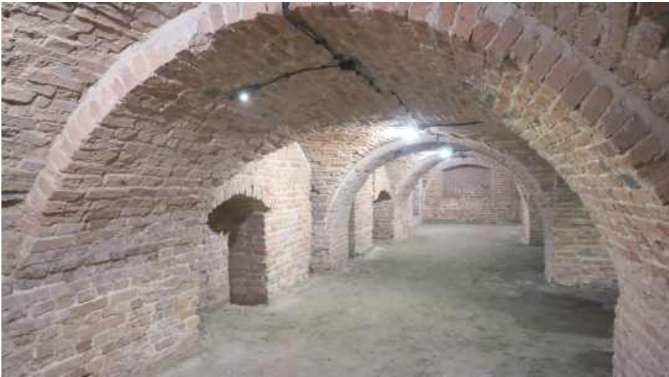
Krypty po zakończeniu prac, fot. Wojewódzki Lubelski Konserwator Zabytków/Delegatura Biała Podlaska
