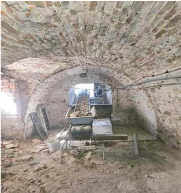
Wnętrza krypt w trakcie prac, fot. Wojewódzki Lubelski Konserwator Zabytków/Delegatura Biała Podlaska
