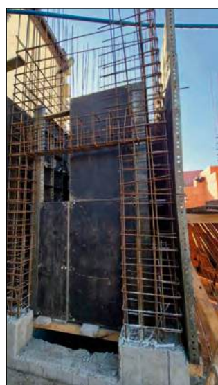
Prace związane z modernizacją remizy w Kamieniu Śląskim trwają.
