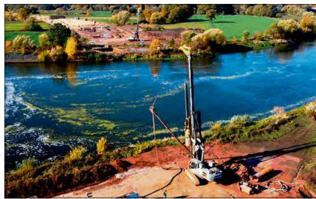
Rozpoczęto prace przy budowie fundamentu środkowej podpory Mostu Południowego.
