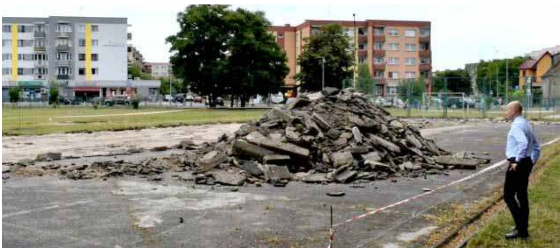
Ruszyły roboty przy budowie dużego, nowoczesnego boiska i bieżni obok Szkoły Podstawowej nr 4
