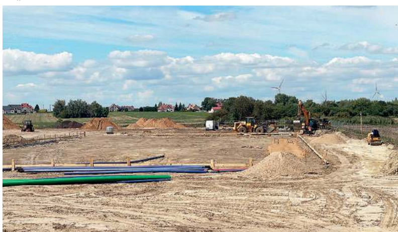
Budowa parku handlowego przy ulicy Prusa
