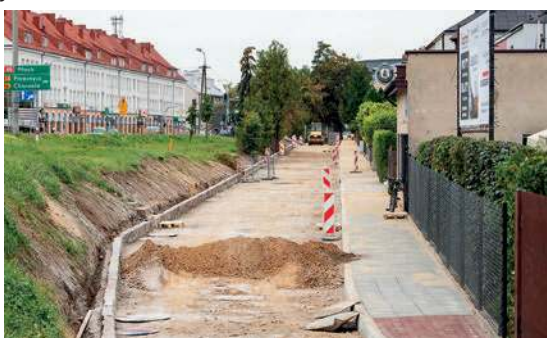
Modernizacja „starego” odcinka ul. Pułtuskiej
