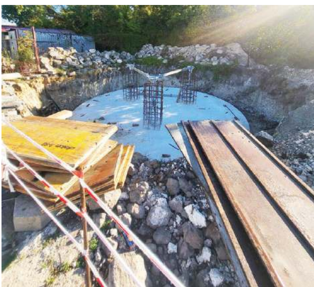
Zostały już wylane fundamenty pod nowy maszt.
