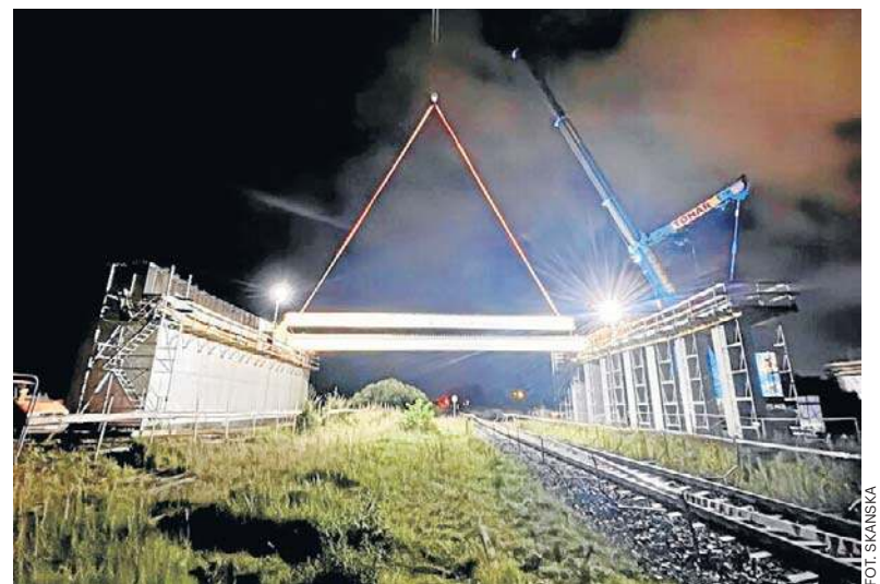
Montaż belek prefabrykowanych na wiadukcie wschodniej obwodnicy nad linią kolejową Wrocław - Sobótka - Świdnica.
