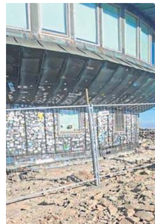
Wykonawca remontu wszedł już na teren obserwatorium na Śnieżce
