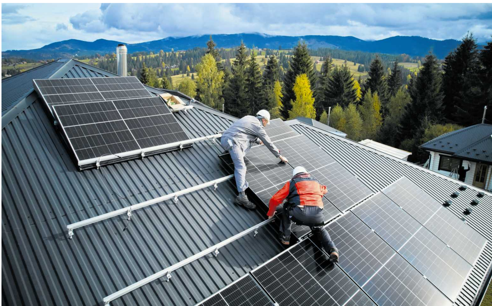
• Instalacja ogniw fotowoltaicznych na dachu domu jednorodzinnego FOT. SHUTTERSTOCK
