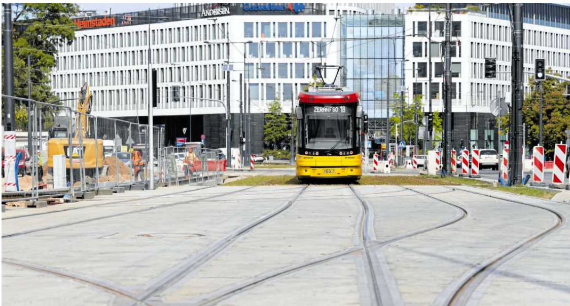
• Tramwaj na ul. Puławskiej na odcinku z czterema torami między Rakowiecką a Goworka
