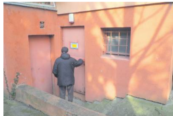
Kotłownia znajduje się w jednym z trzech bloków wyodrębnionych wspólnot
