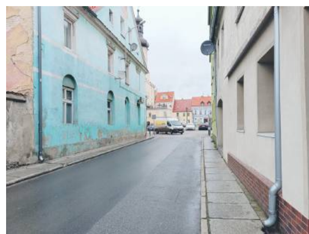
Rusza oczekiwany remont fragmentu ul. Strześlińskiej w Wiązowie
