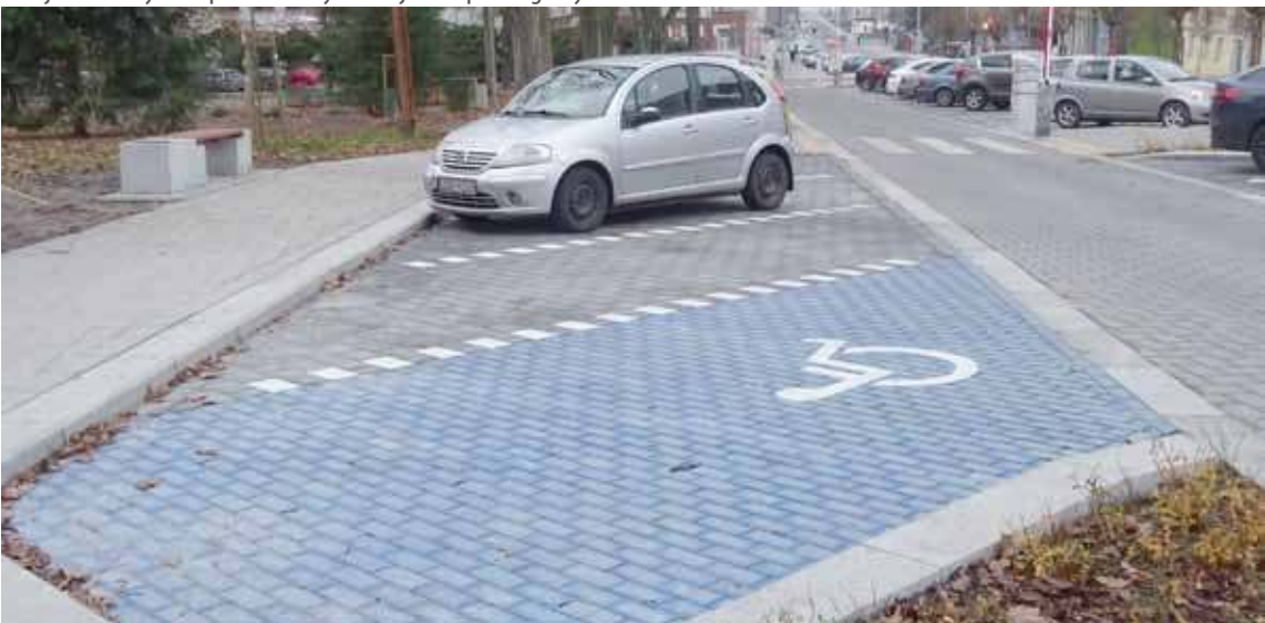
Mini parking powyżej właściwego - jak tu wjechać
