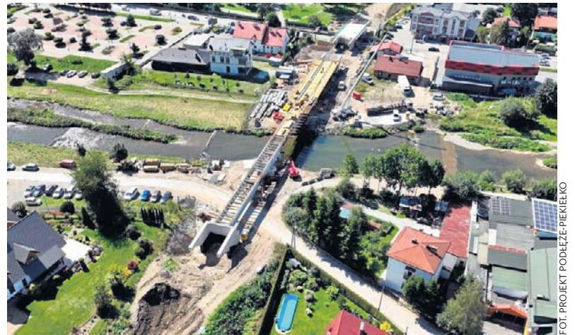
Mszana Dolna. Jednym z nowych obiektów będzie most kolejowy. Jego przesło jest już nad Mszanką
