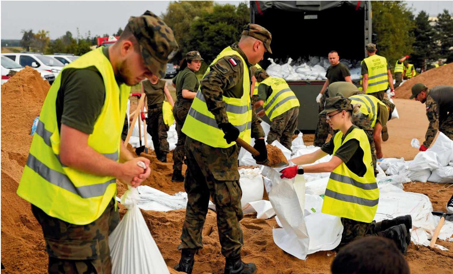
• Wrocławska oczyszczalnia ścieków Janówek. Wojska obrony terytorialnej umacniają wały na brzegu Bystrzycy
