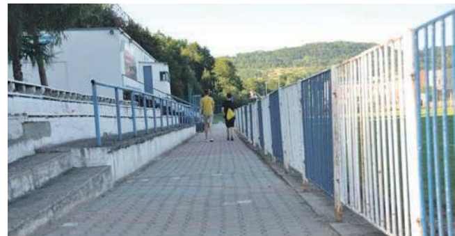
Wzdłuż trybuny zachodniej wyłożona została kostka brukowa
