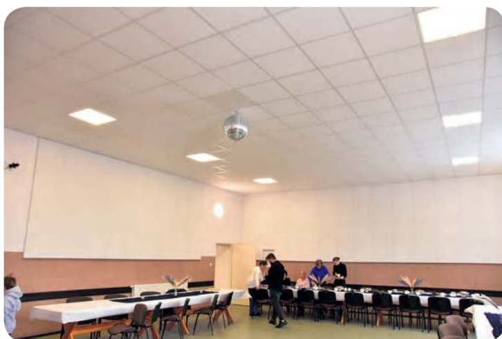
Akustyczne materiały na ścianach i sufitach są bardzo estetyczne.
