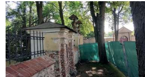
Remont fragmentu muru otaczającego klasztor w Alwerni
