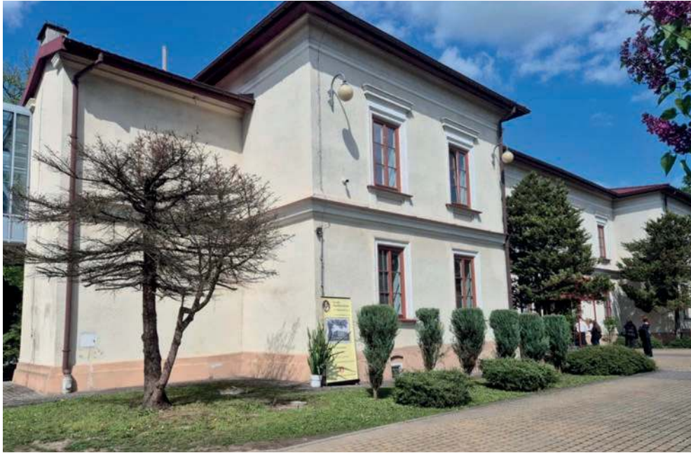
Dach i elewację budynku LO w Krzeszowicach czeka remont
