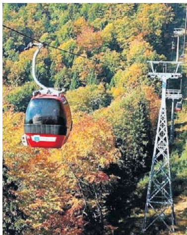
Prace techniczne mają potrwać do 27 listopada
