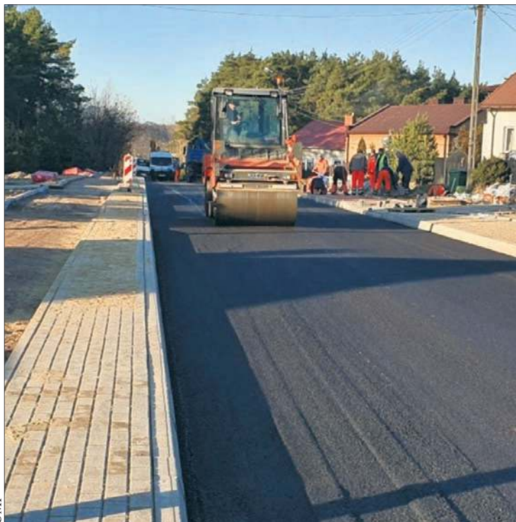
Prace trwają od jesieni ubiegłego roku
