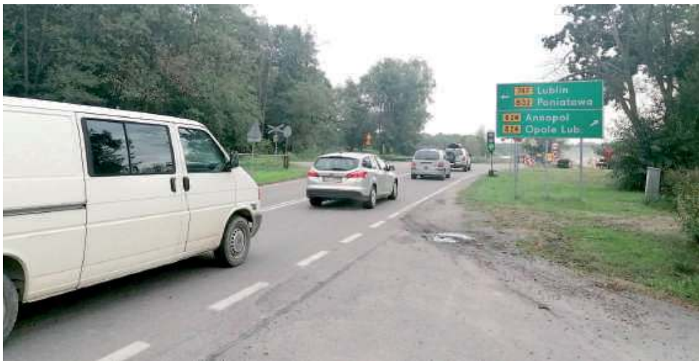
Z uwagi na newralgiczną lokalizację mostu, który znajduje się w pobliżu skrzyżowania dwóch dróg wojewódzkich i gminnej, sygnalizacja świetlna zamontowana została przy czterech wlotach - od Puław, Opola Lubelskiego, Poniatowej i drogi gminnej
