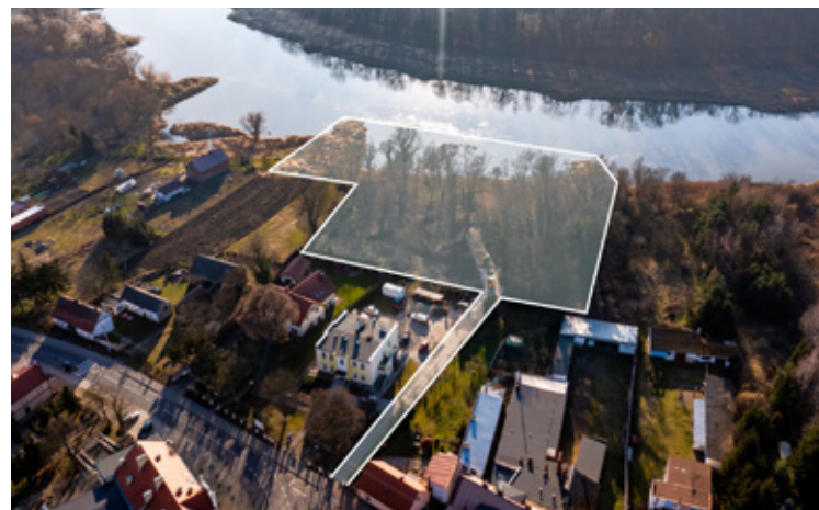
Budowa mariny w Lubiążu trwa.
