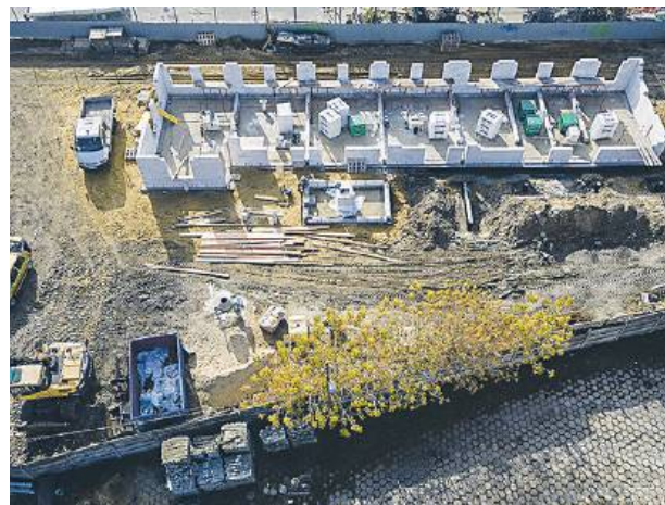
Wykonawca prac rozebrał już stary budynek i uprzątnął gruz z placu budowy. Wykonany został także tzw. stan zerowy budynku.
