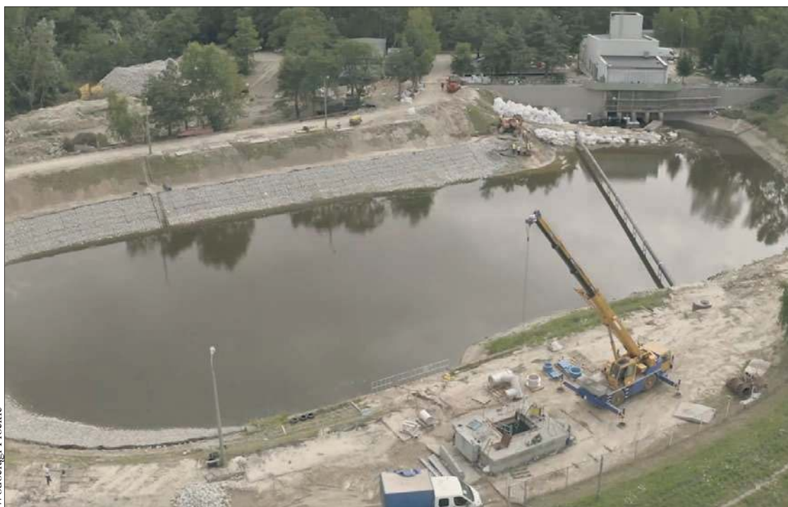
Na stronie internetowej Wodociągów Płockich można obejrzeć krótki film pokazujący postęp prac przy przebudowie powierzchniowego ujęcia wody „Grabówka”
