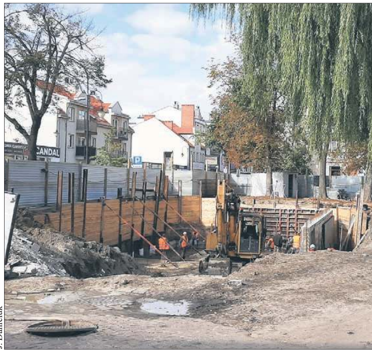
Prace budowlane przy ul. Sienkiewicza 44
