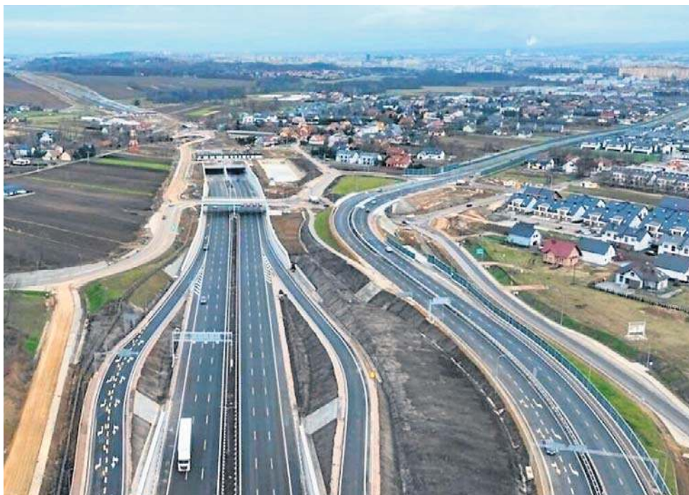
Od węzła w Zielonkach ma się rozpocząć budowa drugiego etapu Trasy Wolbromskiej
