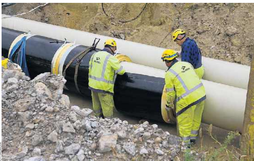
Plac budowy w rejonie Tworzenia w Dąbrowie Górniczej, gdzie aktualnie trwa duża modernizacja sieci ciepłowniczej
