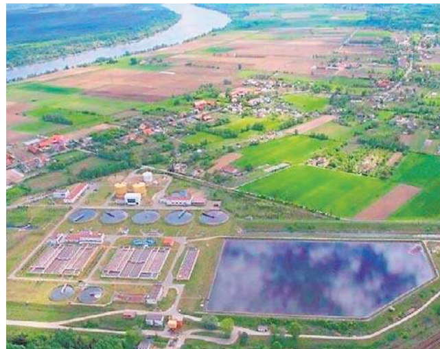
Bydgoska oczyszczalnia Kapuściska
