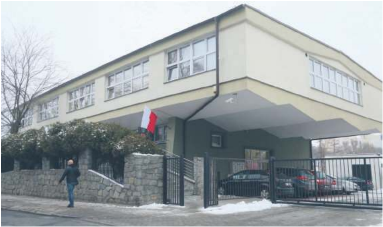
Nowa siedziba m.in. Wydziału Spraw Obywatelskich i Cudzoziemców LUW w wyremontowanym budynku przy ul. Czechowskiej 15
