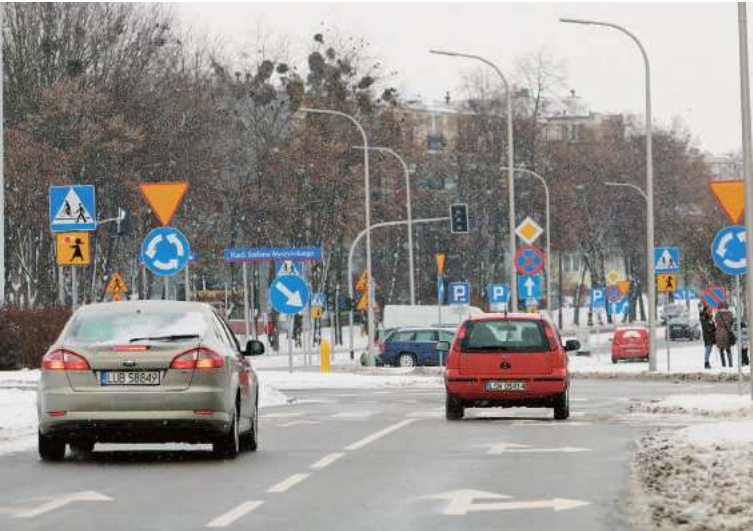
By definitywnie zamknąć przebudowę ulicy Raławickiej, trzeba jeszcze wymalować koperty dla niepełnosprawnych i dodatkowe znakowania poziomego oraz poprawić drobne elementy infrastruktury. Przy obecnej pogodzie może to jeszcze trochę potrwać...
