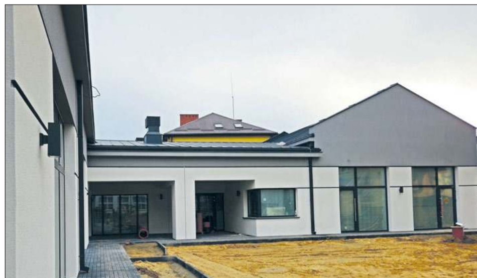
Budowa przedszkola gminnego po ponad dwóch latach zmierza do końca. Spór radnych wokół tej inwestycji wciąż trwa
