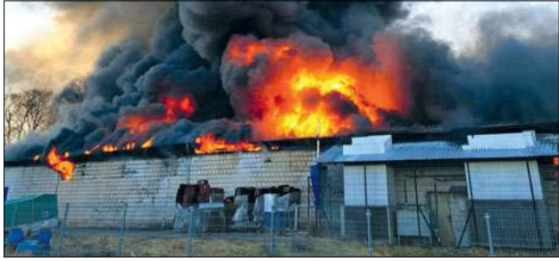
Z ogniem walczyło 26 zastępów i 110 strażaków PSP oraz OSP. Dym unoszący się nad zakładem widoczny był z odległości kilku kilometrów
