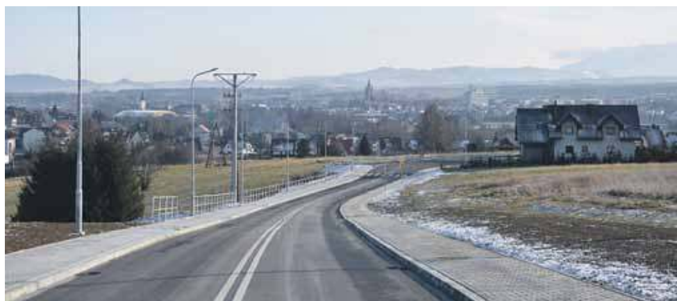
Nowa droga powstała w zaledwie kilka miesięcy, prace rozpoczęły się w maju. Kierowcy mogą oglądać zza kierownicy niezwykle piękną panoramę miasta i... smog.
