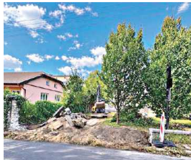
Prace przy budowie nowego objazdu
