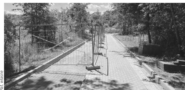
Budowa nowego wjazdu rowerowego do Parku Nagórki-Jaroty w Olsztynie
