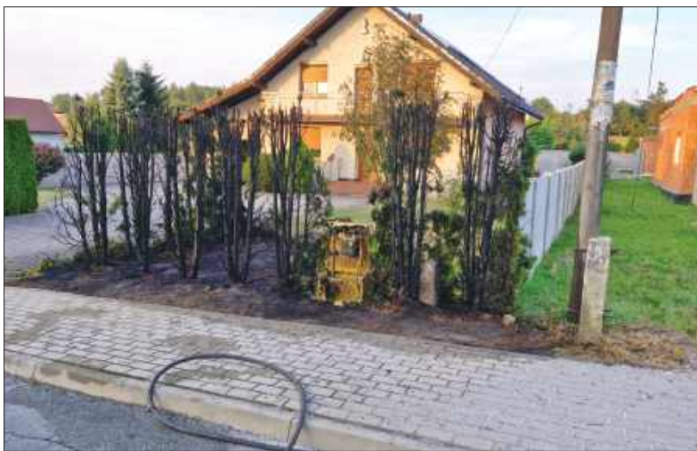
■ Na skutek pożaru doszło do rozszczelnienia części instalacji gazowej.
