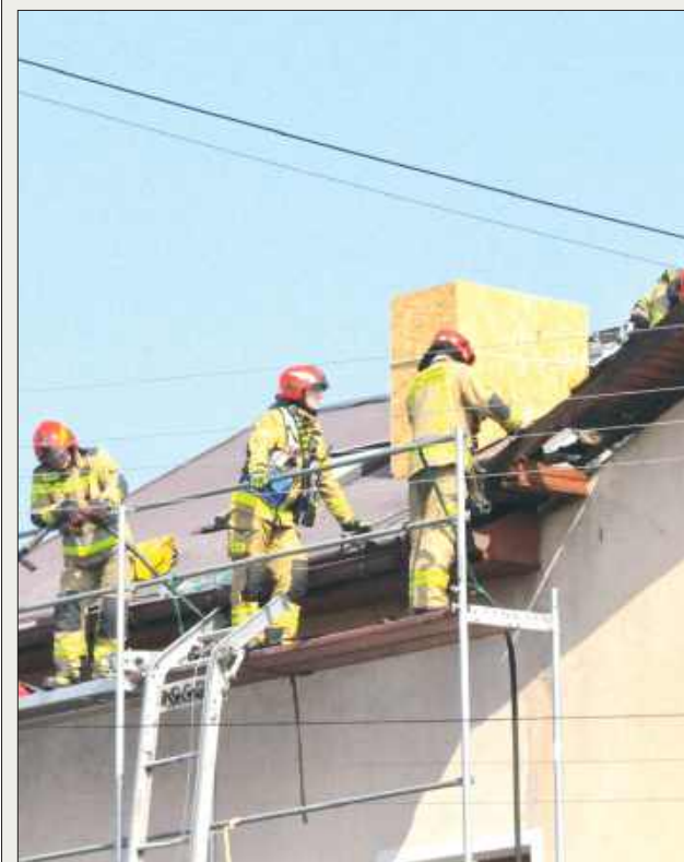
■ To był tzw. pożar ukryty. Strażacy zdemontowali część dachu i usunęli zagrożenie.
