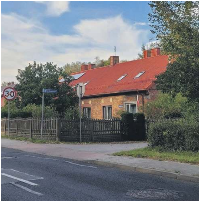
Budynek na rogu Grunwaldzkiej i Sportowej położony jest w niecce i jest najbardziej narażony na podtopienia
