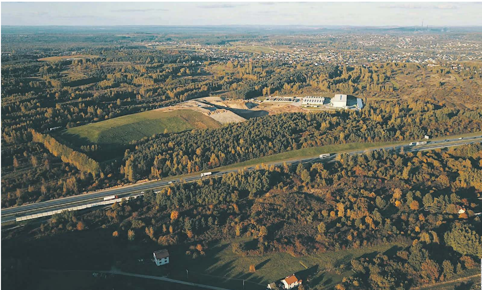
Składowisko odpadów Balinie w sąsiedztwie autostrady A4
