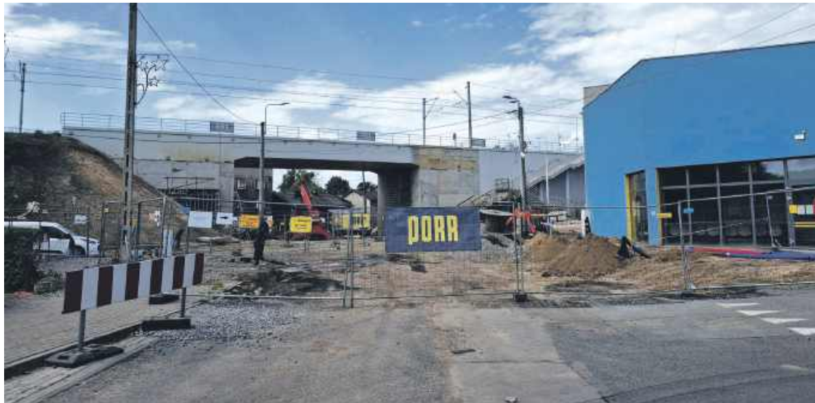
Tak obecnie wygląda plac budowy
