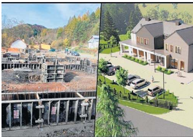
Powstaną żłobek i przedszkole. Budowa już się rozpoczęła – trwają prace przy fundamentach budynku
