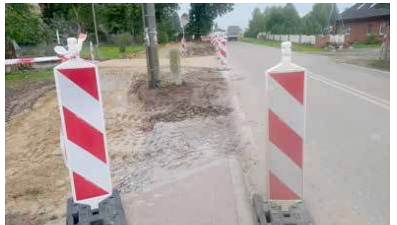
Teren został już przygotowany, na właściwe prace polegające na położeniu nowej nawierzchni chodnika
