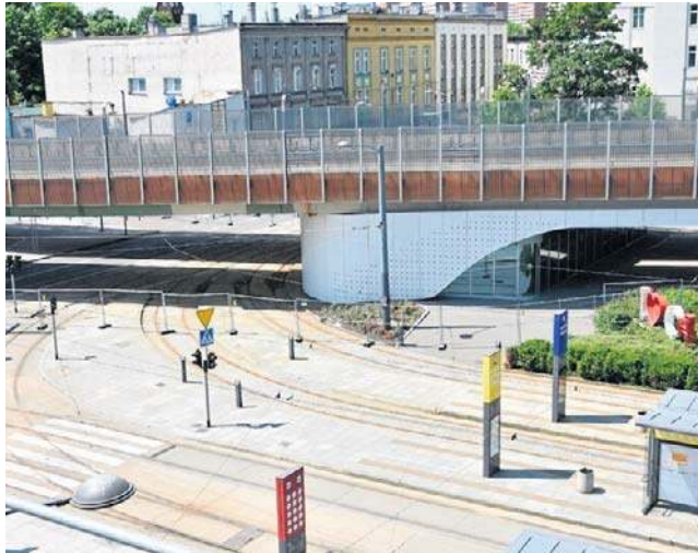
Wyburzenie estakady to - zdaniem radnych - szansa na naprawienie urbanistycznego błędu sprzed pół wieku
