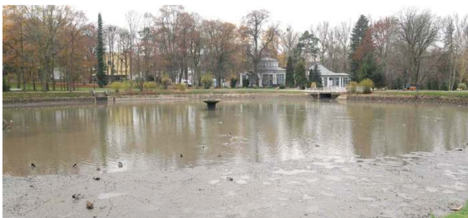
Prace ruszyły z kopyta. Staw w Parku Zdrojowym został już opróżniony z wody
