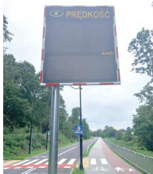
Zastosowano nowoczesny system pomiaru prędkości w celu poprawy bezpieczeństwa
