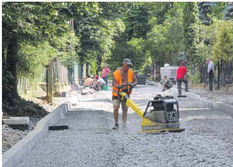
W minionym tygodniu na Brzozowej trwały przygotowania pod położenie nowego asfaltu.
