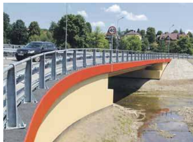
Nowym mostem kierowcy mogą już bezpiecznie przeprawić się na drugą stronę Poniczanki.
