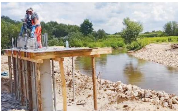
Budowa mostu w Kuclach
