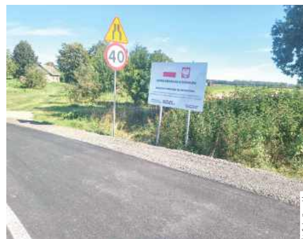
Przebudowana ul. Rejtmanówka w Karczmiskach Drugich. Na 1,8-kilometrowym odcinku powstała nowa nawierzchnia asfaltowa, pobocza i oznakowanie
