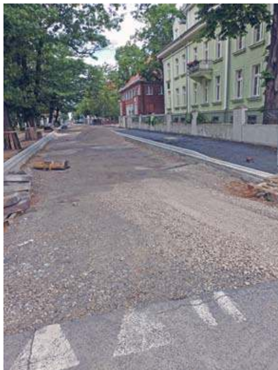
Mocno zaawansowana jest inwestycja przy ul. Bankowej
