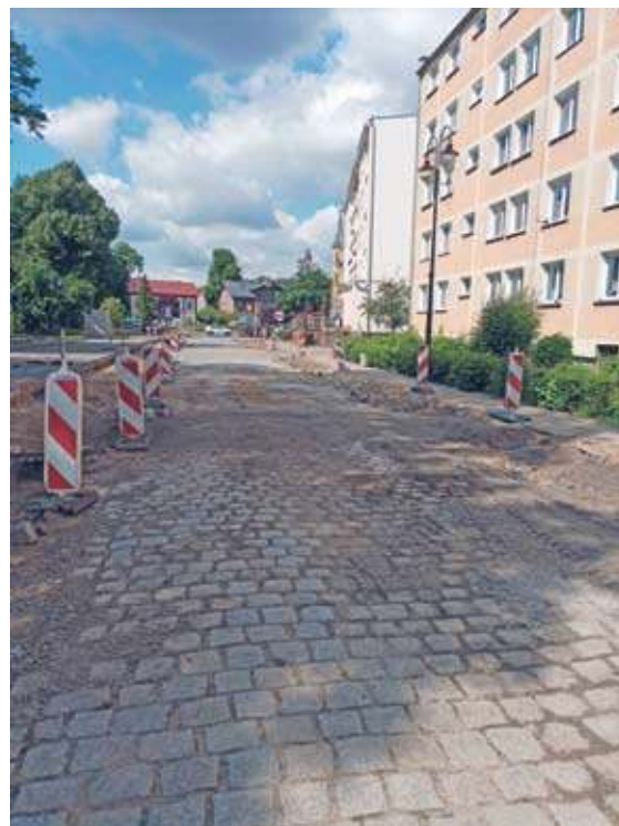
Daleko posunięta jest też przebudowa ul. Dąbrowskiego
