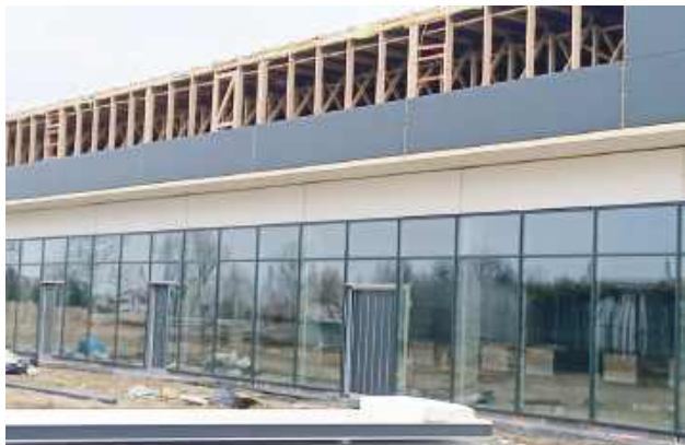
Trwają prace także na pierwszym piętrze nowej galerii
