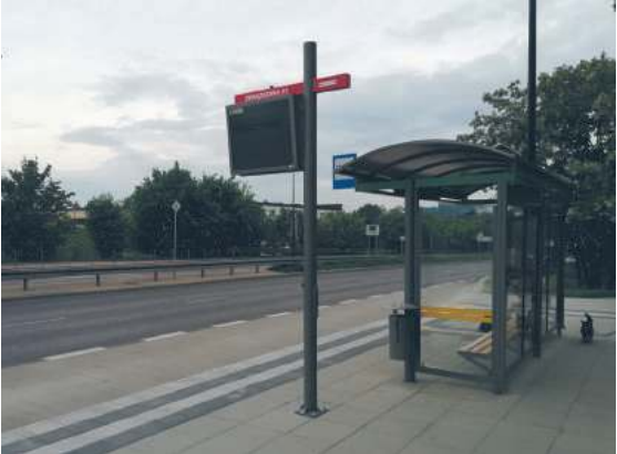
W ramach zespołu przesiadkowego w rejonie ul. Związkowej wybudowano cztery zatoki betonowe wraz z wyświetlaczami informacji dynamicznej i stojakami na rowery
