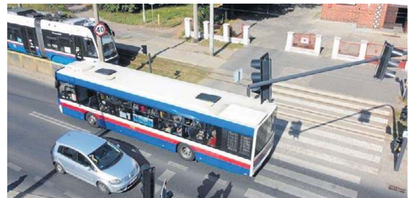
Przez nieco ponad miesiąc trwał remont przystanków tramwajowych i budowa autobusowych
