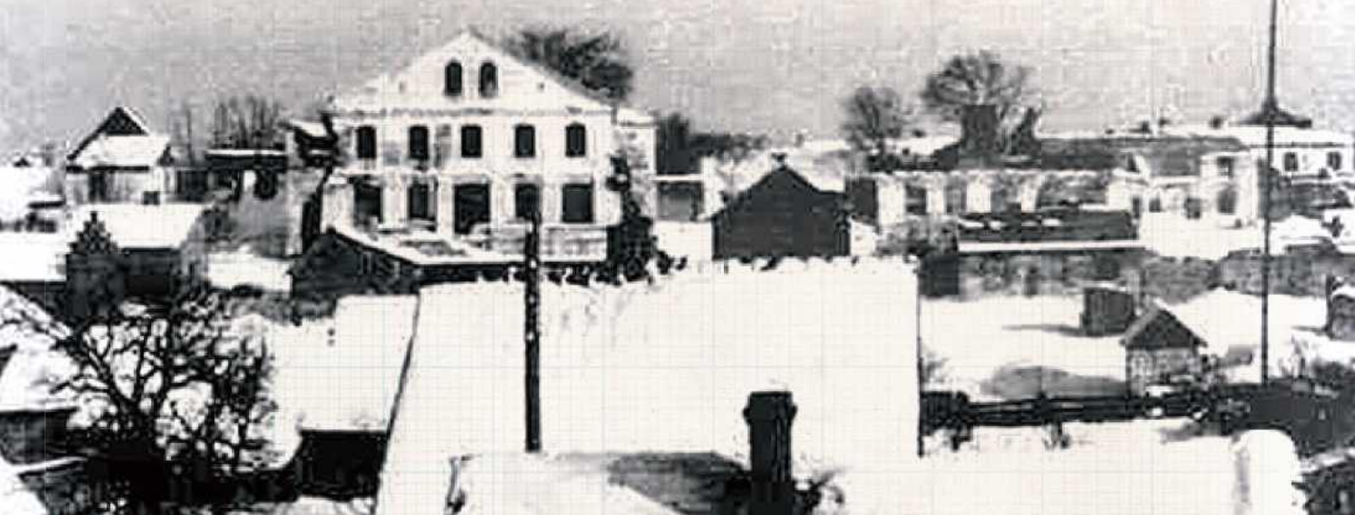
Z lewej, w górnej części zdjęcia, puławska synagoga. Zbudowano ją ok. 1886 roku przy ulicy Zwycięstwa. W tym miejscu dom modlitwy istniał także wcześniej. Została zburzona w czasie II wojny światowej - najpierw uszkodziło ją bombardowanie we wrześniu 1939 r., a potem, po wywiezieniu i wymordowaniu mieszkańców w Sobiborze, rozebrana. Zdjęcie z portalu fotopolska.eu, znalezione na portalu aukcyjnym
