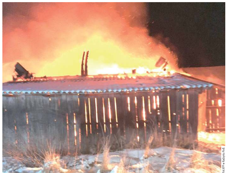
W Ustrzeszy o 3 nad ranem wybuchł pożar w drewnianej stodole, która nie posiadała zasilania w energię elektryczną
