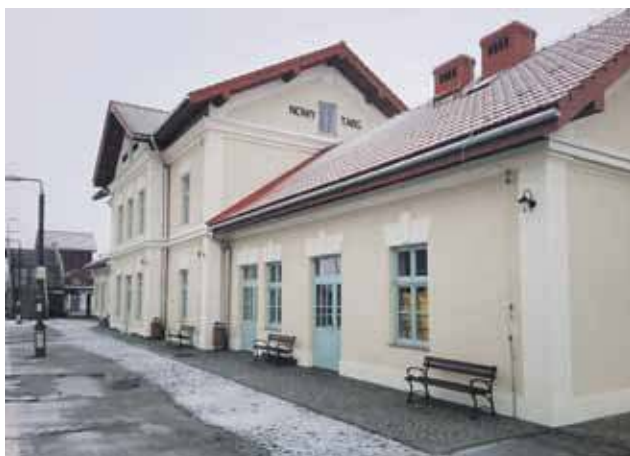
Nowotarski dworzec po remoncie możemy podziwiać, ale wciąż tylko z zewnątrz.
