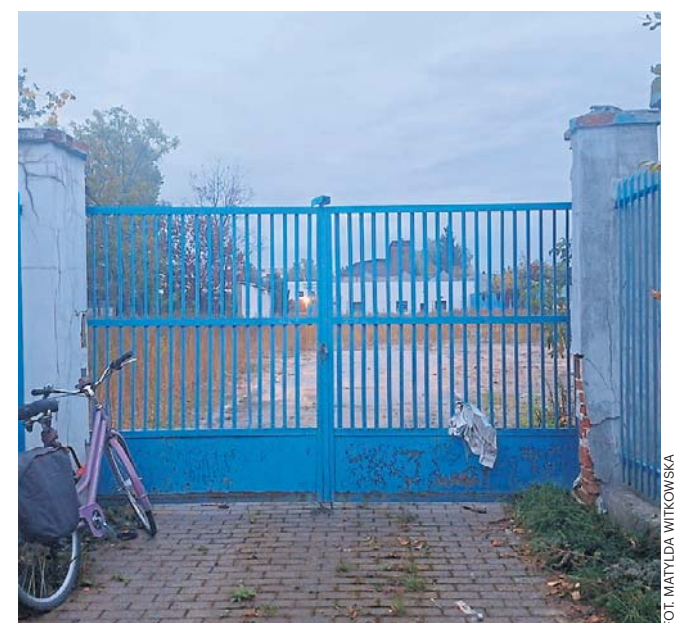
Rozbiórkę przeprowadził Zarząd Lokali Miejskich, prace zakończyły się w lipcu tego roku
